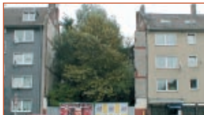
Baulücke an der Segerothstraße
