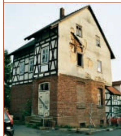
Leer stehendes Fachwerkhaus in Neuental
